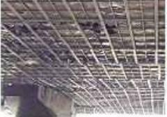
写真4 足場の損傷状況[下面から]
