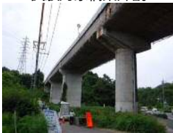
試験対象橋梁外観
