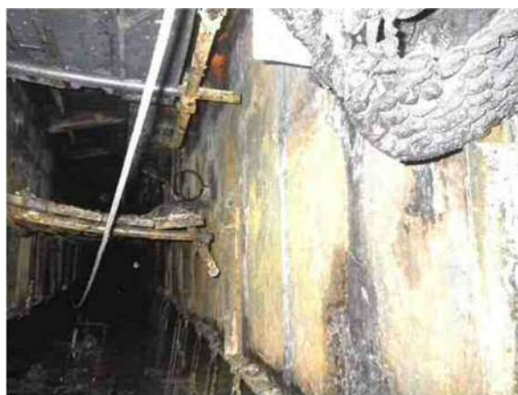
桁の被災状況
