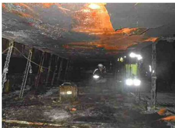
塗膜の被災状況
