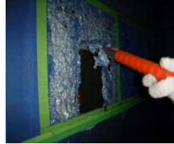
塗膜はく離作業
