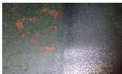
例) はく離作業後 鋼板面の凹部に残存する塗膜の状態
