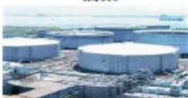
石油貯蔵タンク
