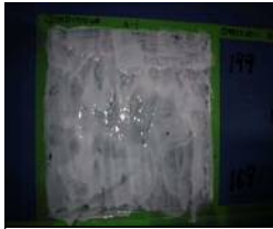
剥離剤塗布完了状態
