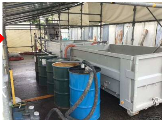
汚水浄化槽及び汚泥回収ドラム
