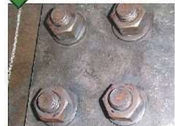
高周波誘導加熱装置による塗膜除去工法。ワイヤースクレーパーによる塗膜除去が困難な部分でも、本工法により塗膜を容易に除去することが可能です。
